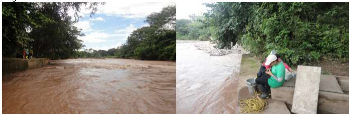
Fotografía 12. Estación 3, Acueducto Casacará
