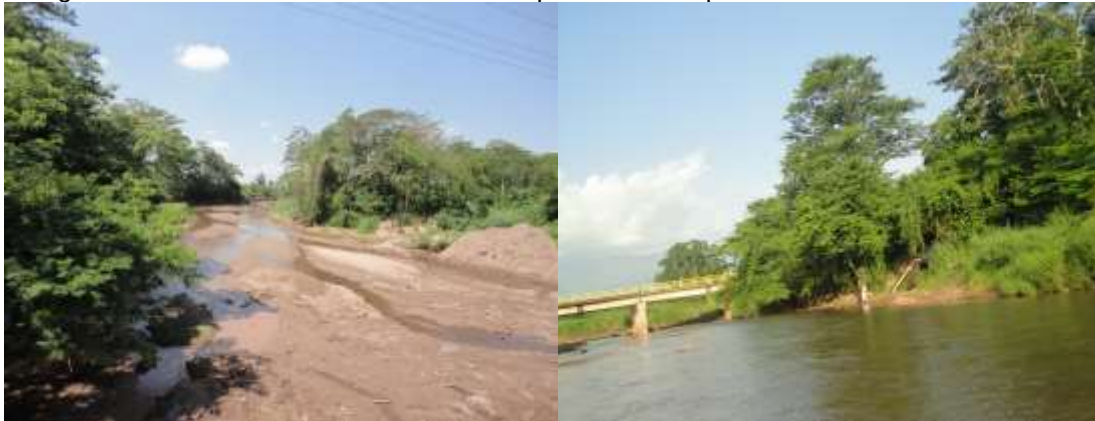
Fotografía 49. Puente Amarillo-río Casacará-periodo seco- periodo lluvias.
