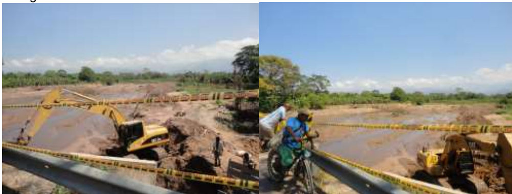
Fotografía 50. Actividad de extracción de material Puente Amarillo-río Casacará.
