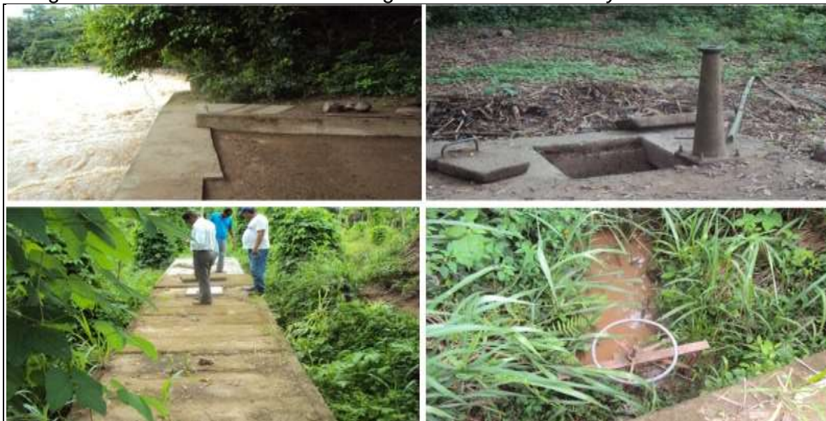
Fotografía 40. Acueducto de los Corregimiento de Casacara y Llerasca.
